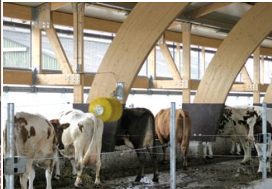
Een verhoging voor de trog zorgt ervoor dat de koeien gemakkelijker bij het voer kunnen.
